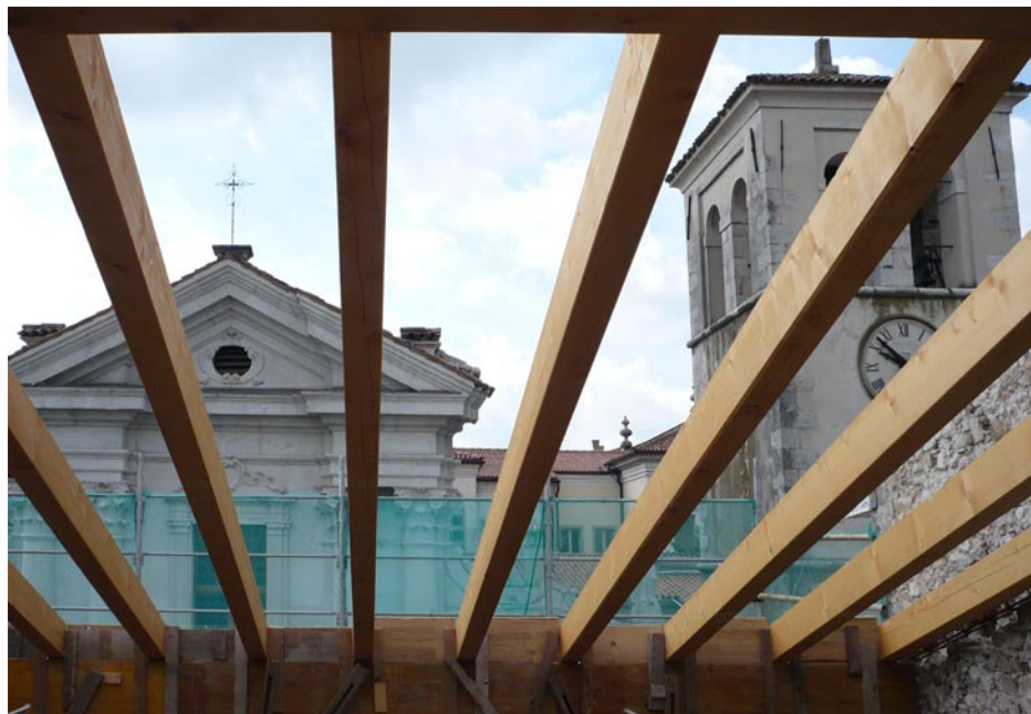
Il tetto della Casa Canonica durante i lavori di restauro
