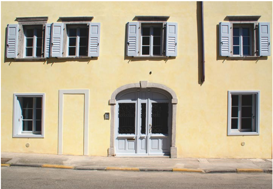
Uno scorcio della facciata della Casa Canonica
