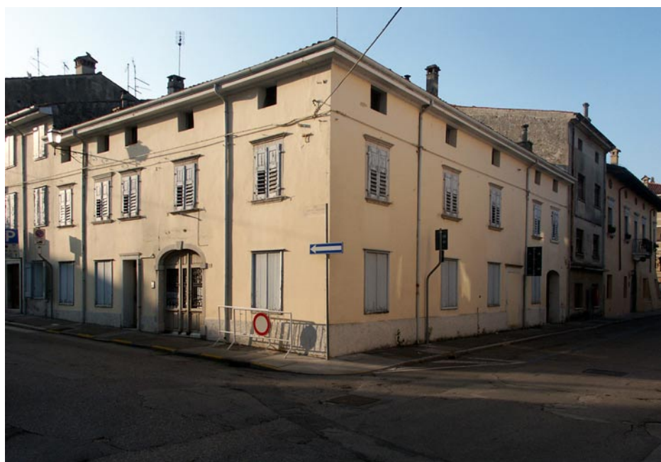
La Casa Canonica prima dei lavori di restauro
