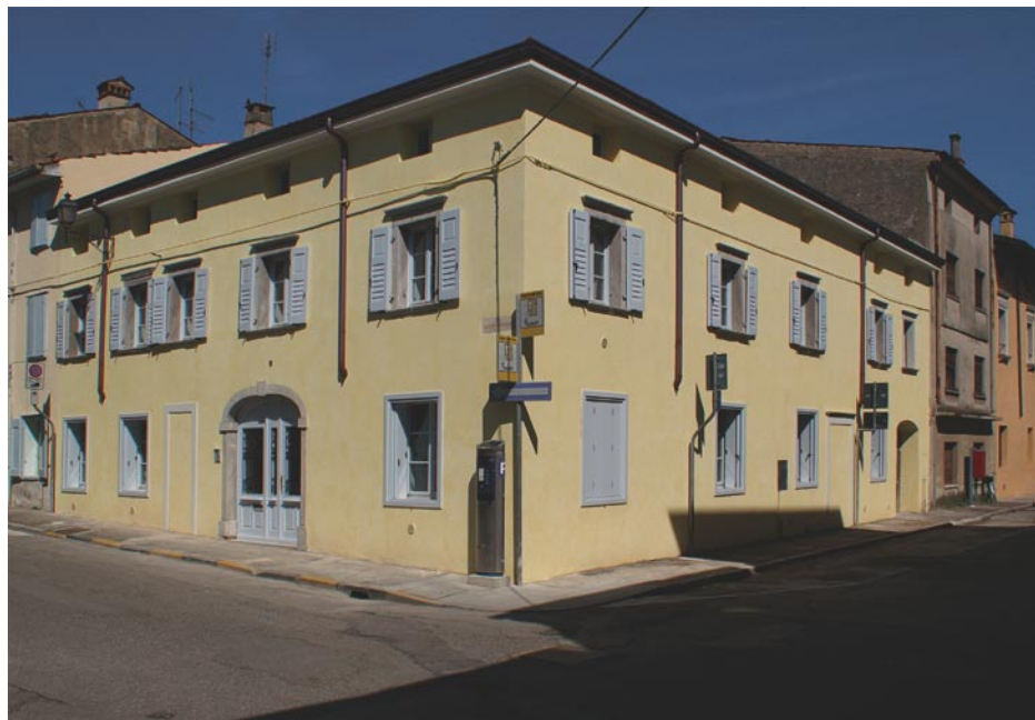
La Casa Canonica alla conclusione dei lavori di restauro
