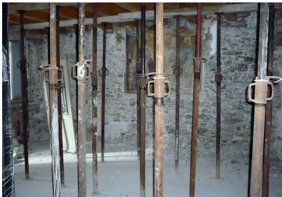
L'Ufficio Parrocchiale durante i lavori di restauro
